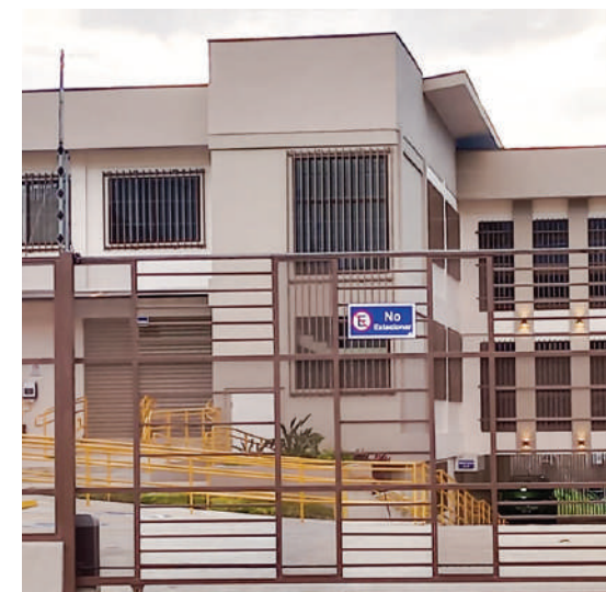
Nueva edificación en San Carlos alberga los despachos que brindan servicios en materia civil, laboral, cobro judicial y defensa pública laboral.
