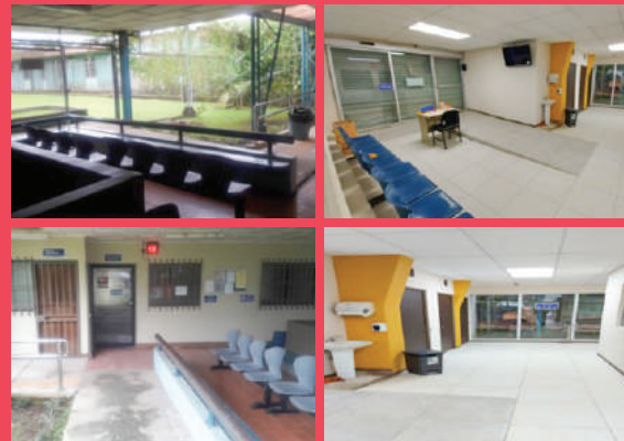
Mejoras en el Edificio Judicial de Sarapiquí se apegan a lineamientos de Ley 7600
