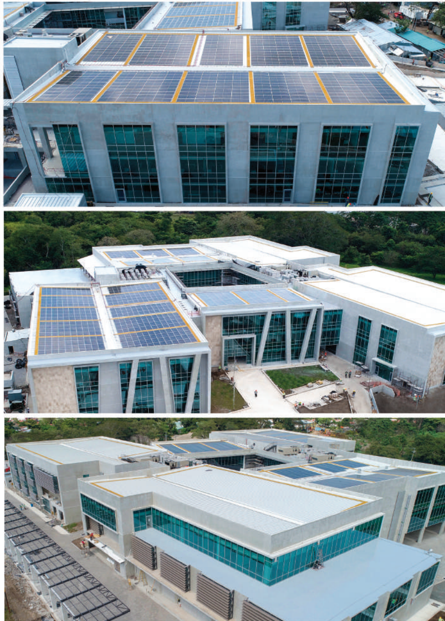
Avance en la construcción del Edificio Tribunales Puntarenas.
